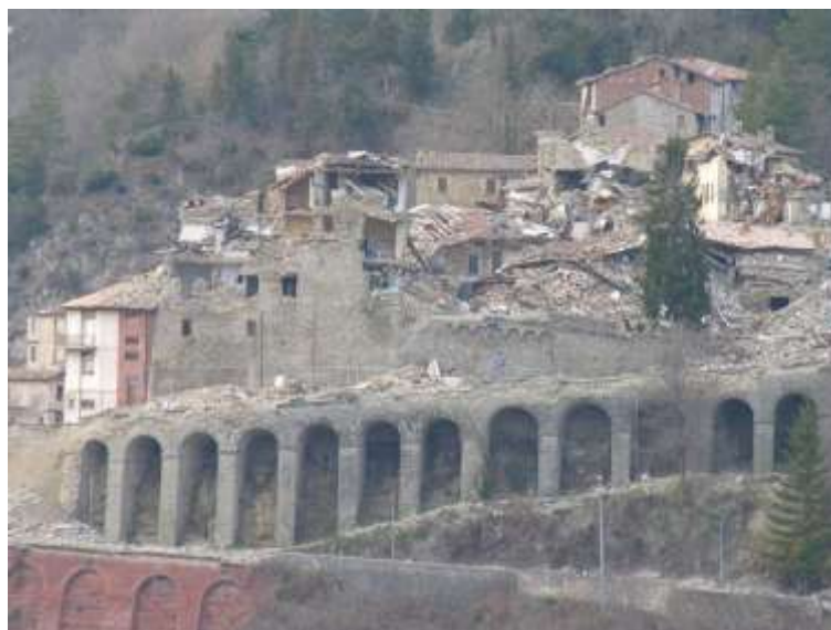
Fig. 1 – Arquata del Tronto dopo la sequenza sismica iniziata il 24 agosto 2016
